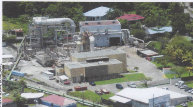
En France, la production d'électricité géothermique - par la centrale de Bouillante (Guadeloupe, 15 MWe) sur la photo et le pilote de Soultz (Haut-Rhin, 1,5 MWe) - devrait monter à 42 MWe en 2016.
