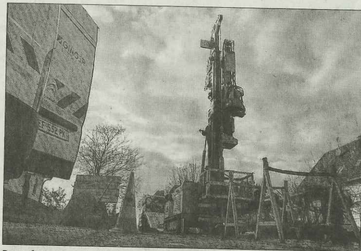
Deux foreuses ont effectué cet hiver des prélèvements de sol à plusieurs endroits du village pour analyse. Ces études se poursuivront tout au long de l'année afin de mieux connaître la géologie locale. Photo DNA/Guillaume Erckert
